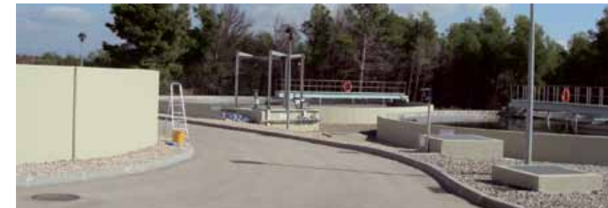
La EDAR del Casalot puede tratar hasta 8.880 m 3 de aguas residuales al día, el equivalente a una población de 45.000 habitantes. Debajo, imagen de la nueva empresa de aguas. Archivo Municipal.
