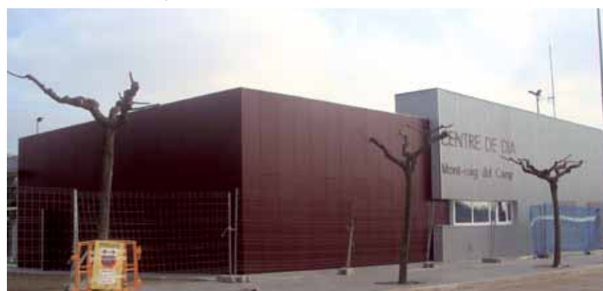
Las obras del Centro de Día están prácticamente listas. Archivo Municipal.
