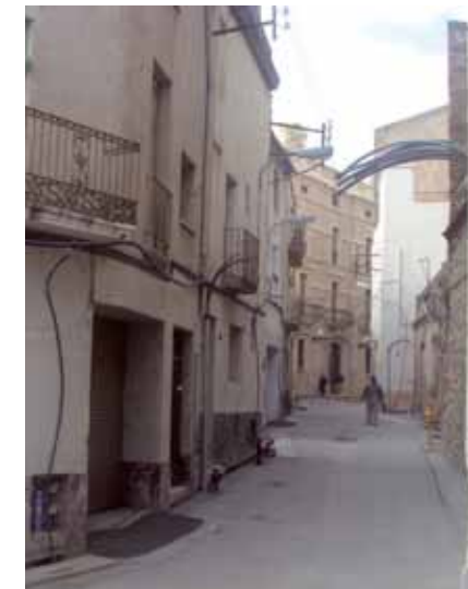
Las obras del casco antiguo, ya en marcha. Archivo Municipal.
